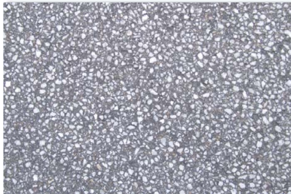
Vaulx-en-Velin - Rue M. de Robespierre
